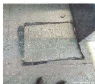
Foto 4: fabricación de tapaderas de concreto en cajas de aguas negras y pluviales.
