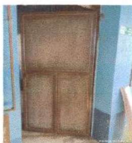
Foto 3: Mejoramiento de puertas con limpieza mas aplicación de pintura anticorrosiva y sustitución de chapa a 17 puertas.
