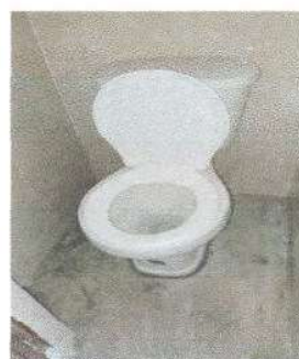
Foto 6: Sustitución de ocho sanitarios con sus respectivos accesorios
