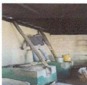
Foto 5: Remozamiento de muro existente de cocina con aplicación de cernido y pintura interior de cocina.
