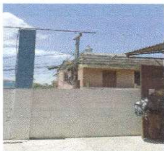
Foto 1: Reparación de muro de construcción de 2.00 por 2.00 metros cuadrados
